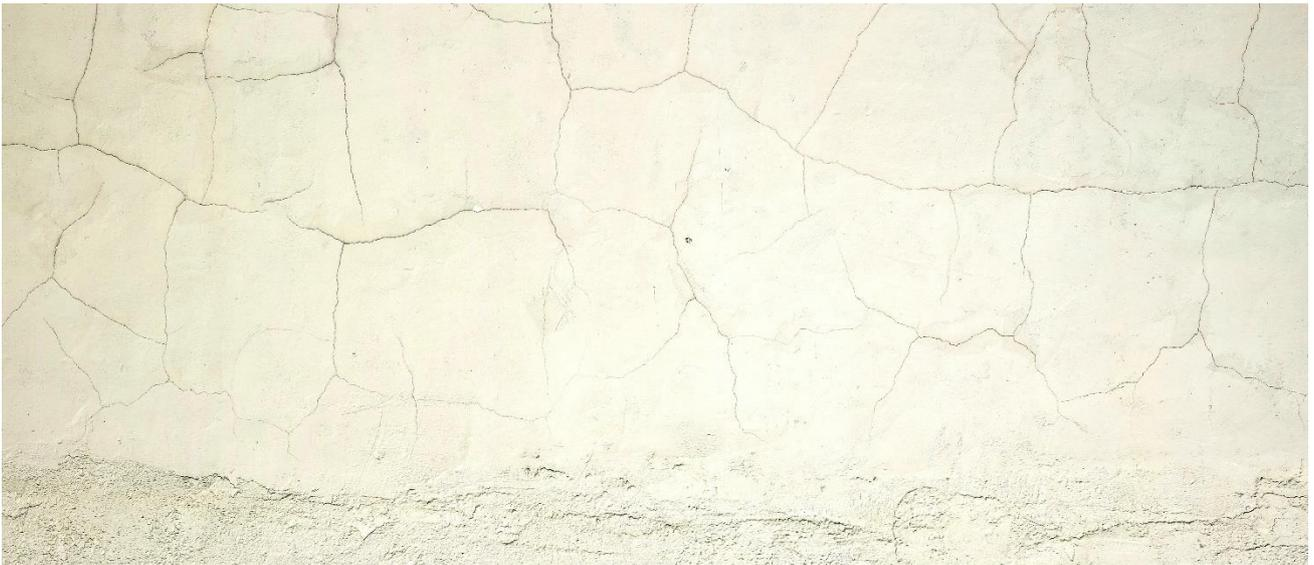
Una de las principales causas de la aparición de **fisuras en las fachadas** son las oscilaciones térmicas a las que se ven sometidas debido a los continuos cambios climáticos, que provocan contracciones y dilataciones en los componentes del cerramiento, incluido el revestimiento, y frecuentemente acaban por producir fisuras en él por incompatibilidad de deformaciones.
