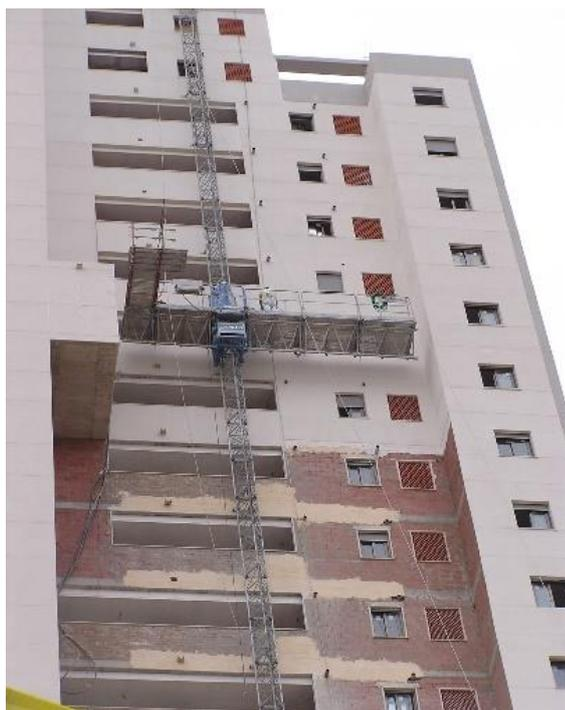
No es extraño encontrar edificios antiguos en los que la pared soporte está formada por distintos tipos de ladrillos cerámicos correspondientes a distintas épocas de construcción, o zonas con antiguas ventanas tapiadas por cambios de uso del edificio. Es posible que alguna parte de la fachada tenga paredes de mampostería y, a partir de una cierta altura, sea de ladrillo.
