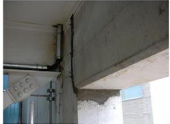
**Colocación de inyectores:** Es recomendable colocarlos entre 20 y 50 cm, en función del espesor de la fisura. Realizar taladros inclinados secantes con la fisura, a ambos lados de esta y al "tresbolillo", a fin de garantizar el máximo número de intersecciones, ya que las fisuras no siempre siguen un plano perpendicular al del soporte.
