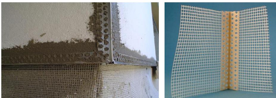
Las esquinas deben estar protegidas con perfiles metálicos, que sirven para reforzar puntos críticos y obtener verticalidad y uniformidad. Se recomienda el uso de esquineros con malla.
