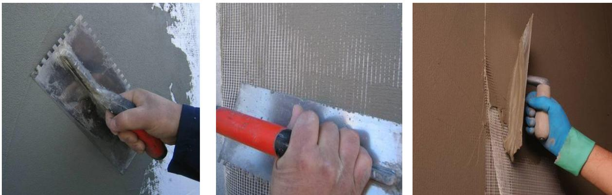
Sobre el mortero base se coloca la malla cuyo tejido debe penetrar mediante presión sobre la primera capa de mortero fresco.
