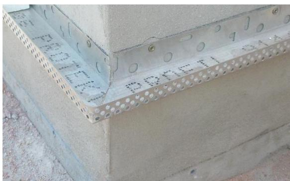
Se colocan antes de las placas de aislamiento, horizontalmente en el límite inferior de la zona a revestir. Antes de fijar el perfil de arranque debe de respetarse un zócalo de mínimo 15 mm, para evitar la transmisión de humedad por capilaridad.
