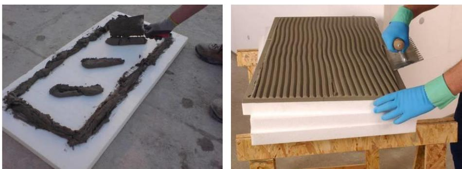
Extender un cordón perimetral y pelladas centradas sobre el reverso de la placa aislante.
