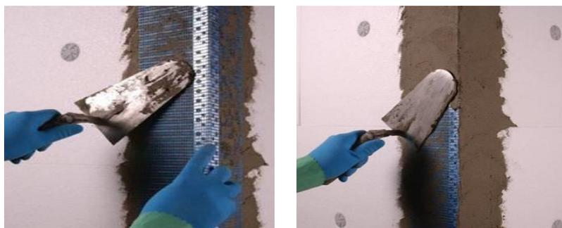
Presionar sobre la malla para embutirla en el mortero, y tapar la malla con otra capa de mortero.
