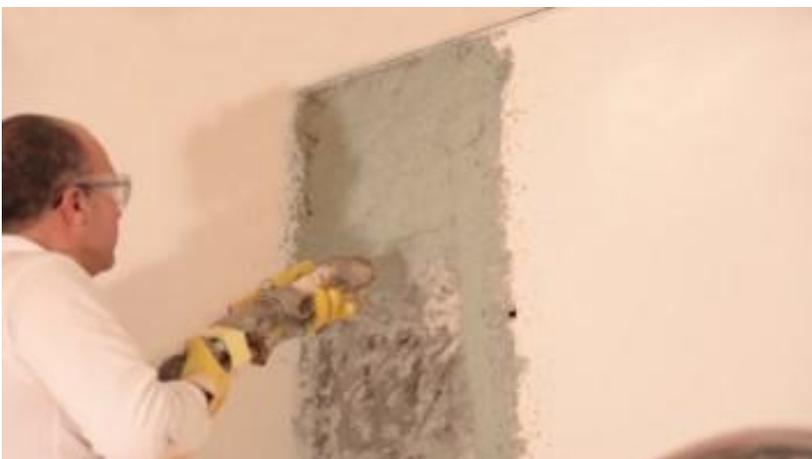
Para ello se debe obtener un soporte cohesivo, libre de partículas sueltas o mal adheridas o cualquier sustancia que reste adherencia a los tratamientos a realizar. Para mejorar la adherencia se debe generar una superficie rugosa de poro abierto y humedecer el soporte hasta saturación evitando el encharcamiento.
