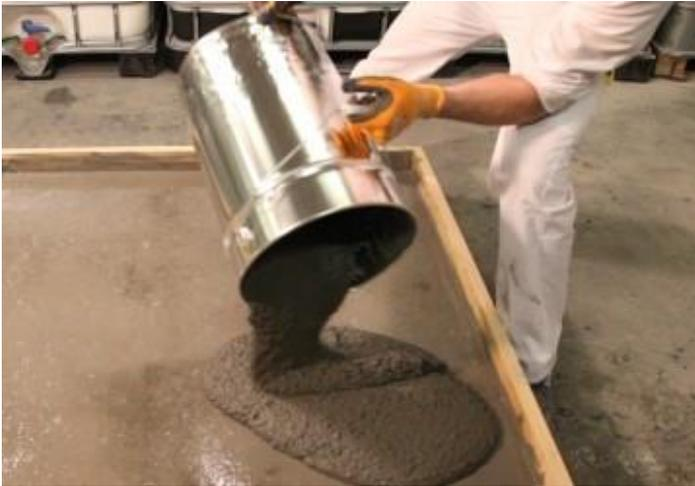
Para la reparación de elementos complejos, o cuando se requiere regenerar áreas que presentan problemas de acceso, se utiliza el vertido o relleno (método 3.2 según UNE-EN 1504-9).
