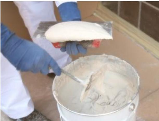
Tradicionalmente, la reparación localizada de los daños y defectos en el hormigón se realiza con morteros de aplicación manual (método 3.1 según UNE-EN 1504-9). Existen morteros de aplicación manual monocomponentes y bicomponentes para reparaciones en general y también para usos más específicos (aligerados, de fraguado rápido...).
